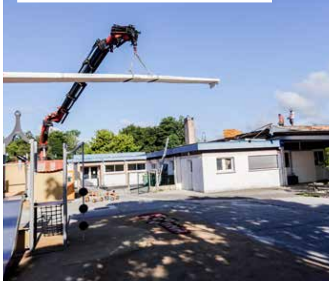
Travaux d'aménagement de la cour d'école maternelle Carrié - Magudas
