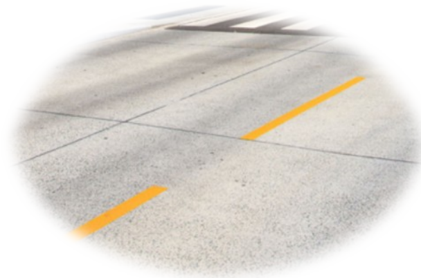
Plateforme bus en enrobé percolé grenailé
