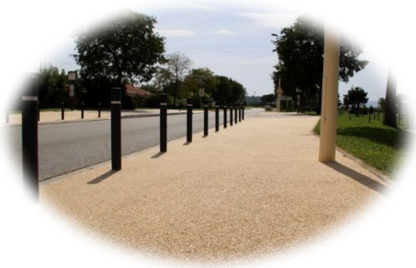
Voie verte en enrobé drainant clair
