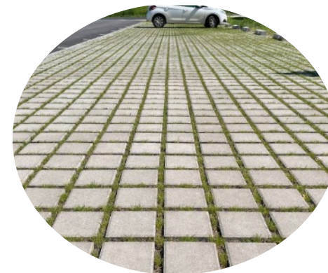
Stationnement en pavés béton à joints enherbés
