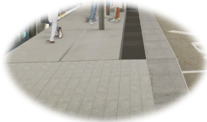
Station bus en dalles et pavés béton
