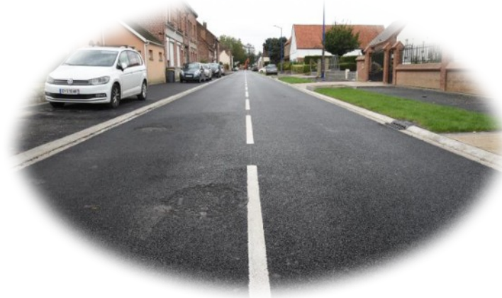
Voirie et entrées charretières en enrobé noir
