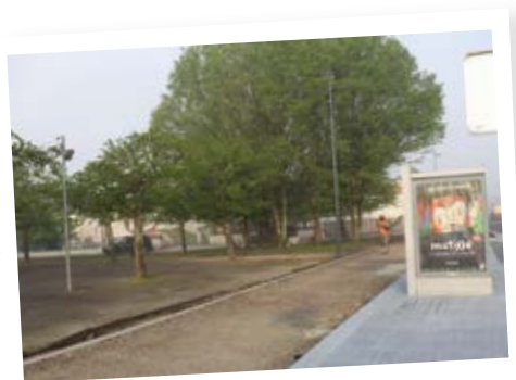
Achèvement des travaux de la place d'Issac.
